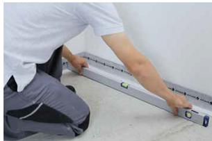
Todos los sustratos deben estar planos con una variación mínima de 6 mm en 3 m (1/4" en 10') según la planicie requerida en las guías de la TCNA o TTMAC, o según las
