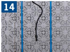
Coloque los sensores de piso entre dos cables calefactores. Se proporcionan dos sensores: uno con los termostatos ARDEX FLEXBONE HEAT y el otro con el cable calefactor del ARDEX FLEXBONE HEAT.
