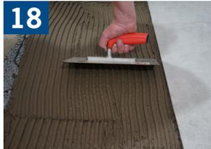
Peine el mortero adicional sobre la membrana prellenada, con la llana dentada apropiada para el tamaño de la loseta o piedra que se instalará, y coloque directamente la loseta o piedra en la parte superior. Esta aplicación puede ocurrir "mojado sobre mojado". Alternativamente, permita que el mortero prellenado o la base autonivelante ARDEX cure al menos 16 horas antes de peinar el mortero adicional.
