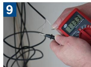
9 **PRUEBA #1:** antes de instalar los cables calefactores, pruebe la resistencia total de los cables calefactores. Cualquier cable defectuoso debe ser reemplazado
