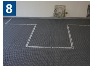
8 Las áreas donde no se colocarán cables calefactores deben ser identificadas antes de la instalación y omitidas durante la colocación de los cables calefactores según el plan de preinstalación
