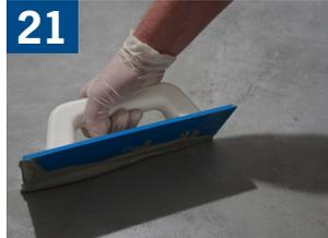
Para enlechar, use ARDEX FL™ Lechada (boquilla) flexible con arena y de fraguado rápido, ARDEX FH™ Lechada/boquilla con arena para pisos y paredes o ARDEX WA™ Adhesivo y boquilla epoxi de alto desempeño y 100% sólidos.
