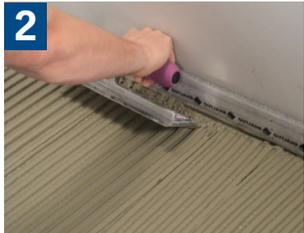
2 Peine el mortero sobre un área no mayor a la que pueda cubrir la membrana ARDEX FLEXBONE HEAT durante el tiempo abierto del adhesivo. Si el mortero se endurece, debe eliminarse por completo mecánicamente e instalar
