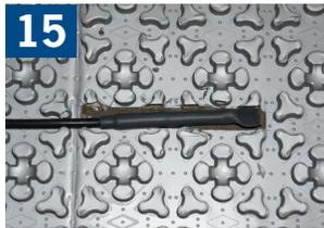
Presione el extremo del sensor de piso en la membrana. Para instalaciones sin impermeabilización, se puede hacer un corte longitudinal en la membrana para acomodar el sensor.
