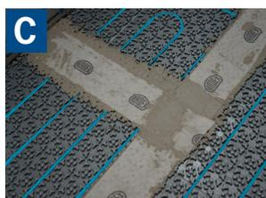
Durante la instalación de las losetas o piedras (ver a continuación), aplique una capa del mortero a la ARDEX TLT™ Cinta para juntas.
