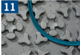
Los cables calefactores se colocan alrededor de las cruces y entre las rectas. Este patrón único permite la colocación radial del cable para evitar daños. Evite doblar el cable calefactor sobre sí mismo, un radio de curvatura menor a 1.6 mm (1/16") podría dañar su envoltura.
