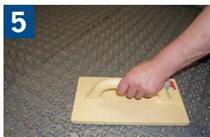
5 Usando llana de goma, llana plana o un rodillo de 15,8 a 34 kg (35 - 75 lb), alise e incruste la membrana en el mortero de adhesión.
