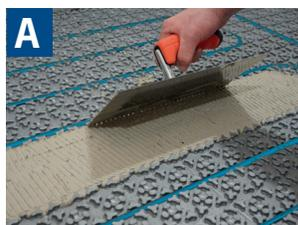
Aplique el mortero en la membrana ARDEX FLEXBONE HEAT, sobre las juntas y/o en las áreas de conexión de componentes estructurales adyacentes.
