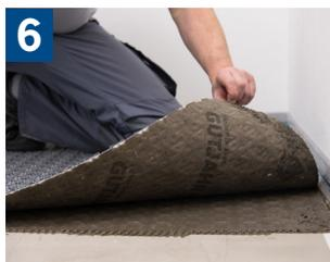
6 Al acercarse a las paredes u otros obstáculos, corte la membrana a la longitud adecuada con un cuchillo o con las tijeras ARDEX FLEXBONE. Deje aproximadamente 6 mm (1/4") entre la membrana y el borde de la pared o del
