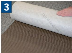
3 Coloque cuidadosamente la membrana ARDEX FLEXBONE HEAT en el adhesivo ARDEX húmedo con el lado afelpado hacia abajo y el lado de plástico expuesto hacia arriba.
