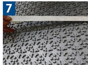
7 En el caso de juntas estructurales y de dilatación, las membranas deben separarse al ancho especificado de al menos 9 mm (3/8"). Las juntas perimetrales de campo para subdividir grandes áreas de cobertura se forman en la membrana ARDEX FLEXBONE HEAT. La disposición de las juntas en la instalación de losetas o piedras debe estar en línea con las separaciones de las membranas.
