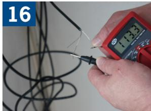
**TEST #2:** Antes de rellenar la membrana, compruebe la resistencia total de los cables calefactores. Los cables defectuosos deben sustituirse.
