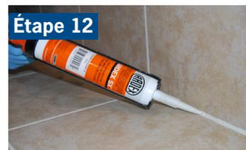
Remplir les joints de mouvement et de périmètre avec ARDEX SX, le produit de scellement et la colle de construction multi-usage ARDEX CA 20 PMC ou un produit de remplissage flexible approprié.
