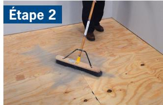
Balayer et aspirer les débris du support. Dans les endroits soumis à une humidité intermittente ou lorsqu'une imperméabilisation est nécessaire les supports sensibles à l'humidité, comme le gypse, doivent être protégés contre les dommages causés par l'eau en appliquant de l'apprêt ARDEX P 51<sup>MC</sup> et du composé d'isolation et d'étanchéisation des fissures ARDEX 8+9<sup>MC</sup>.
