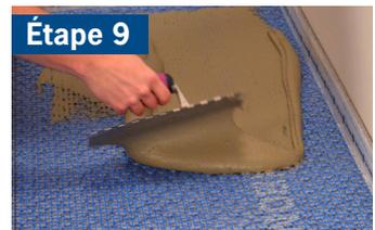
Avec le côté plat d'une truelle, remplir et lisser la membrane ARDEX UI 720 FLEXBONE avec un mortier ARDEX approprié afin qu'il soit à égalité avec le dessus du treillis.
