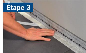
Tout le long des murs périmétriques et sur le pourtour des colonnes, des tuyaux, des placards et des autres pénétrations dans le plancher, ainsi que des structures contraignantes, utiliser les bandes isolantes pour rebord ARDEX UD 146 comportant un pied adhésif autocollant.
