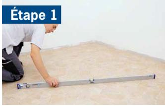
Vérifier que le support peut soutenir des charges, qu'il est plat et que sa structure est solide. Si un nivelage est requis, un produit comme l'ARDEX Liquid BackerBoard peut être utilisé.
