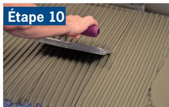
Peigner le mortier avec une truelle dentelée appropriée, puis procéder à l'installation des carreaux ou des pierres directement sur la membrane.
