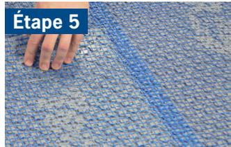
Juxtaposer les sections de la membrane en utilisant l'extension du treillis autoadhésif. Faire chevaucher les membranes adjacentes.
