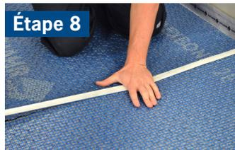
Couvrir les joints avec des bandes autoadhésives pour joint de mouvement ARDEX UD 156 afin de les protéger du mortier et du coulis.
