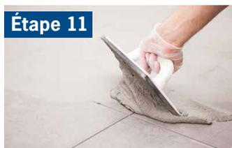
Le temps de cure du mortier requis avant la pose du coulis peut varier en fonction des propriétés des membranes en plastique, du type de mortier, du type de carreaux, de la taille des carreaux et des conditions climatiques. Les mortiers ARDEX pouvant être utilisés avec les membranes de désolidarisation ARDEX permettent habituellement l'application du coulis dans les 3 à 24 heures.
