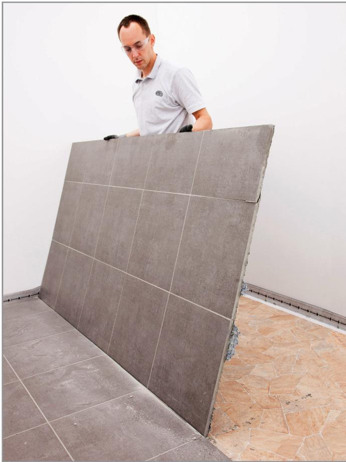
Si le revêtement de sol doit être remplacé fréquemment, étendre une feuille de plastique sur le support avant l'installation de la membrane ARDEX UI 720 FLEXBONE. La feuille sert de couche de séparation entre le support et la membrane pour la protéger contre adhérence du mortier utilisé pendant l'installation des carreaux ou des pierres.
