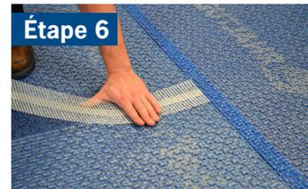
Utiliser le treillis isolant de juxtaposition ARDEX UD 158 pour réunir les extrémités et les parties coupées excédentaires de la membrane ou le treillis original n'est plus.
