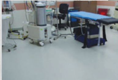
ARDEX MC™ Sistema control de humedad ARDEX K 15® Base autonivelante premium (antes de instalar piso de goma)
