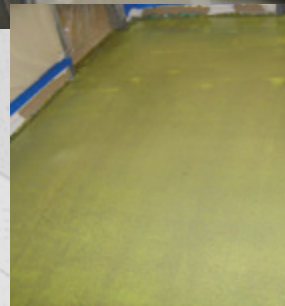
ARDEX MC™ Sistema control de humedad ARDEX K 15® Base autonivelante premium (antes de instalar piso de vinilo en rollo)
