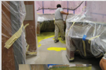
ARDEX MC™ Sistema control de humedad ARDEX K 15® Base autonivelante premium (antes de instalar piso de goma)
