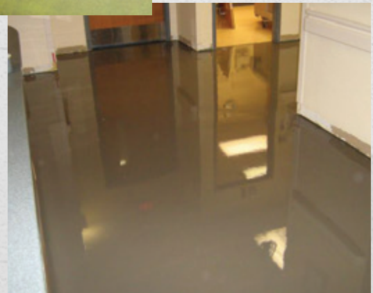
ARDEX MC™ Sistema control de humedad ARDEX K 15® Base autonivelante premium (antes de instalar piso de vinilo en rollo)
