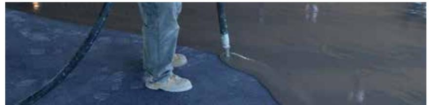
Sous-couche autonivelante de haute capacité **ARDEX HC 100<sup>MC</sup>**
