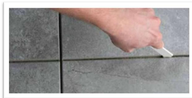
Laissez Laissez le mortier sécher comme il est détaillé le relevé des données techniques, et puis nettoyez les joints de coulis en enlevant tout excès de mortier. Également, nettoyez la surface du pavé et laissez sécher. Lorsque la surface est sèche, mélangez et appliquez le coulis sablé à prise rapide ARDEX FL™ ou le coulis époxy ARDEX WA™ conformément au relevé des données techniques correspondant, et placez-le dans les joints de coulis.
