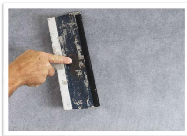
Installez la membrane ARDEX TLT en tant que pare-vapeur\* avec un mortier ARDEX sur le support en pente et placez du côté du plastique du ruban ARDEX US 420 ProDrain, couvrant la nappe. Veuillez consulter le relevé des données techniques de l'ARDEX TLT pour obtenir des renseignements sur l'application.
