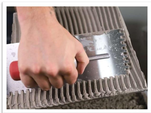
Appliquer à plat à la truelle et ensuite peigner le mortier à l'arrière du carreau ou de la pierre en utilisant une truelle brettelée de 6 mm x 10 mm (1/4 po x 3/8 po). Toujours appliquer le mortier dans le carreau, PAS sur l'ARDEX A 14 et installer humide sur humide.
