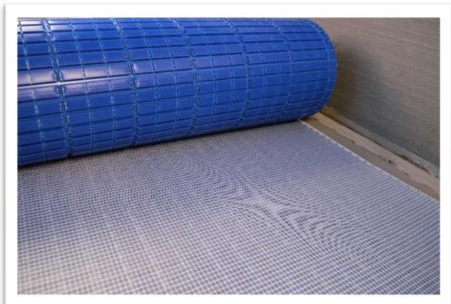
Roulez le tapis en place et coupez le format désiré en utilisant des ciseaux ARDEX FLEXBONE ou un couteau utilitaire. Assurez-vous que la membrane d'imperméabilisation ou le pare-vapeur n'est pas coupé(e).
