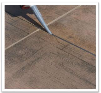
Laissez le mortier sécher comme il est détaillé le relevé des donnés techniques, et puis nettoyez les joints de coulis en enlevant tout excès de mortier. Également, nettoyez la surface du pavé et laissez sécher. Lorsque la surface est sèche, On peut utiliser le scellant en silicone à 100 % ARDEX SXMC pour appliquer une perle flexible de scellant dans les joints et autour du périmètre. On peut aussi laisser les joints libres.
