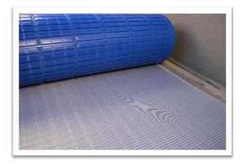
Roulez le tapis en place et coupez le format désiré en utilisant des ciseaux ARDEX FLEXBONEMD ou un couteau utilitaire. Assurez-vous que la membrane d'imperméabilisation ou le pare-vapeur n'est pas coupé(e).
