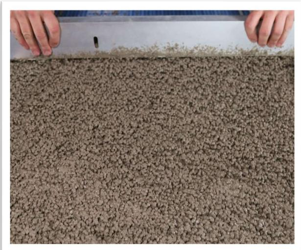
Mezcle ARDEX A 14 Mortero de drenaje con agregado de 2 a 8 mm (5/64" - 5/16") según las instrucciones de instalación de la ficha técnica. Instale con un espesor mínimo de 5 cm (2"). El mortero de drenaje no está limitado por un espesor máximo. Se puede usar un torno aprobado para proporcionar refuerzo adicional, pero no es necesario. Continúe con el siguiente paso de la instalación inmediatamente mientras Mortero de drenaje aún esté mojado.
