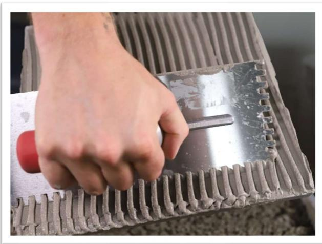
Use una llana plana y luego peine el mortero hasta la parte posterior de la loseta o piedra con una llana dentada de 6 mm x 10 mm (1/4" x 3/8"). Aplique siempre el mortero sobre la loseta, NO sobre de Mortero de drenaje, e instálelo húmedo sobre húmedo.
