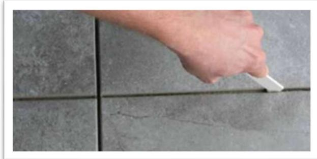
Dejar secar el mortero según lo indicado en la ficha técnica y, a continuación, limpiar las juntas de lechada para eliminar cualquier exceso de mortero. Limpiar también la superficie de losetas o adoquines y dejarla secar. Una vez la superficie esté seca, mezcle y aplique ARDEX FL™ Lechada flexible con arena y de fraguado rápido o ARDEX WA™ Lechada epoxi, de acuerdo con la ficha técnica correspondiente, y colóquela en las juntas de lechada.
