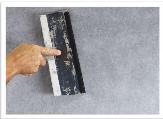
Instale la membrana ARDEX TLT como retardante de vapor\* con un mortero ARDEX sobre el substrato inclinado y colóquelo hasta el lado plástico de la cinta ARDEX US 422 ProDrain, cubriendo el vellón. Consulte la ficha técnica de ARDEX TLT para obtener información sobre la aplicación.
