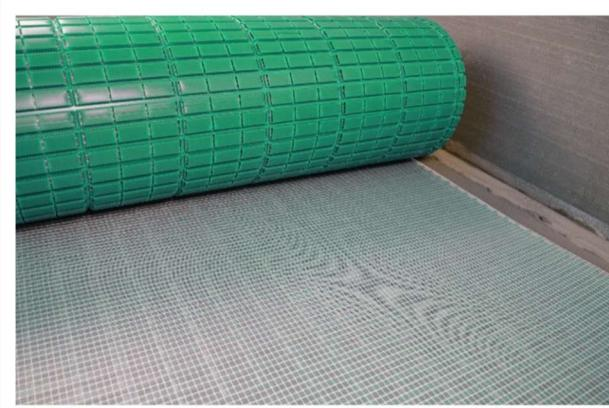
Pase un rodillo sobre la manta en su sitio y córtela a la medida con las tijeras ARDEX FLEXBONE o una navaja. Asegúrese de que la membrana impermeabilizante o retardante de vapor no esté cortada.
