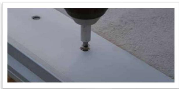
Coupez et installez le format approprié de profil ProFin et les coins ProFin intérieurs et extérieurs sur le périmètre de l'aire d'installation. Placez des attaches galvanisées aux deux trous ou au besoin pour fixer les profils.
