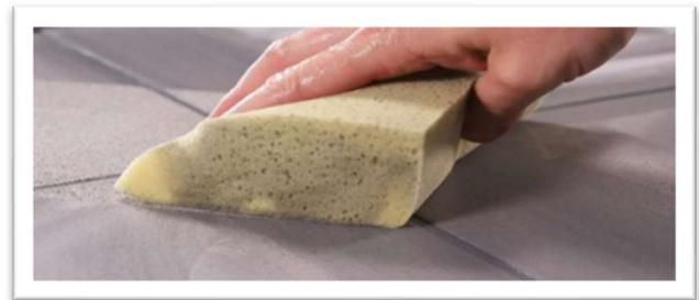
REMARQUE: le coulis ne doit PAS être appliqué autour du pourtour. Toutes les installations doivent inclure des joints mous en utilisant le scellant en silicone à 100 % ARDEX SXMC conformément aux normes ANSI A 108.01-3.7 et TCNA EJ 171.
