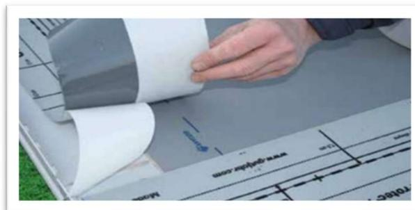
Instale la cinta ARDEX US 420 ProDrain a lo largo del borde interior del perfil ProFin. Asegúrese de que la cinta cubra todos los sujetadores. La línea de puntos de la cinta debe estar alineada con el borde interior del perfil ProFin.
