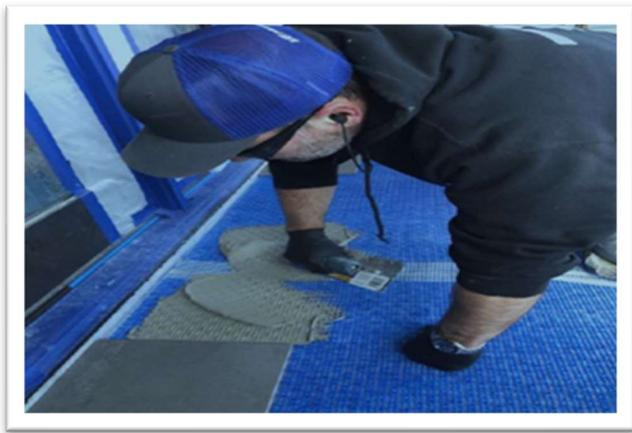
La instalación debe realizarse de acuerdo con la norma A 108.5 de ANSI. Después de mezclar, aplique el mortero directamente sobre el tapete con el lado plano de una llana dentada (presionando) para obtener una adhesión mecánica sólida.
