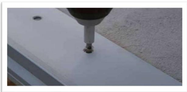
Corte e instale el perfil ProFin del tamaño adecuado y las esquinas ProFin internas y externas en el perímetro del área de instalación. Coloque sujetadores galvanizados en cada dos orificios, o según sea necesario, para asegurar los perfiles.
