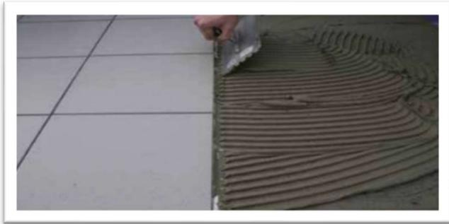
Appliquez l'ARDEX X 90™ OUTDOOR à l'arrière du carreau ou de la pierre en utilisant une truelle plate, puis installez le carreau.
