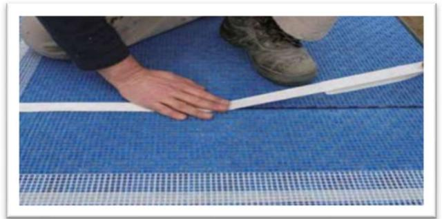
L'espace entre les draps de sol qui respectent les joints de mouvement et de transition doit être couvert avec du ruban pour empêcher que le mortier et le coulis pénètrent dans le support en dessous pour éviter de lier le tapis au support.
