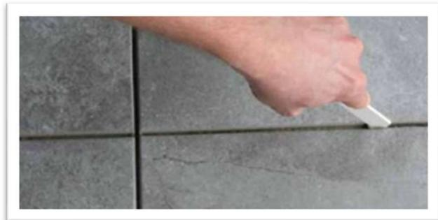
Laissez l'ARDEX X 90 sécher pendant deux heures (21 °C/70 °F), puis nettoyez les joints de coulis en enlevant tout excès de mortier. Également, nettoyez la surface du carreau ou de la pierre et laissez sécher. Lorsque la surface est sèche, mélangez et appliquez le coulis sablé à prise rapide ARDEX FL<sup>MC</sup> ou le coulis époxy ARDEX WA<sup>MC</sup> conformément au relevé des données techniques correspondant, et placez-le dans les joints de coulis.
