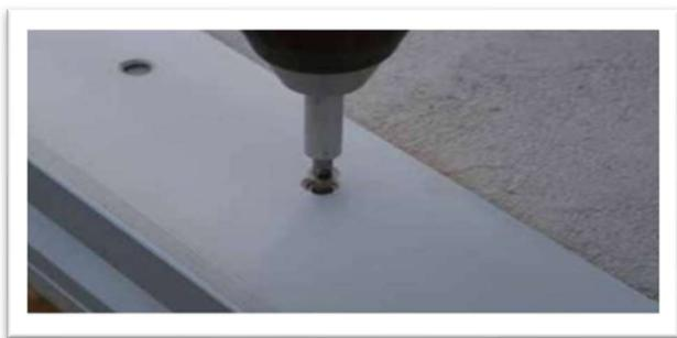
Coupez et installez le format approprié de profil ProFinMD et les coins ProFinMD intérieurs et extérieurs sur le périmètre de l'aire d'installation. Placez des attaches galvanisées aux deux trous ou au besoin pour fixer les profils.
