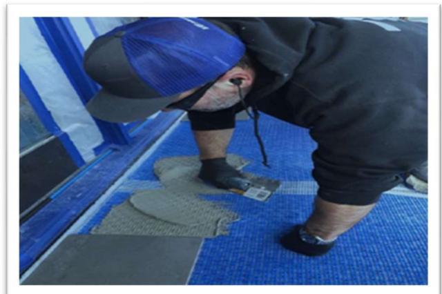
L'installation doit s'effectuer conformément à la norme ANSI A 108.5. Après l'avoir mélangé, appliquez le mortier directement sur le tapis avec le côté plat d'une truelle brettelée (en tapant) pour obtenir un lien mécanique solide.
