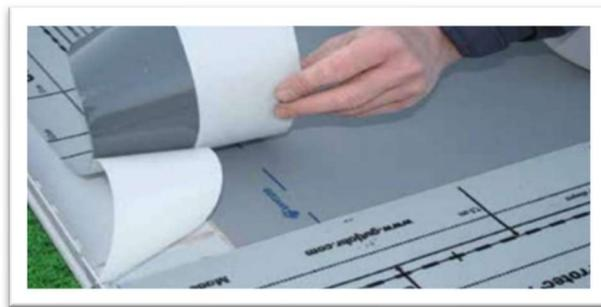
Installez le ruban ARDEX US 420 ProDrain le long du rebord intérieur du profil ProFin. Assurez-vous que le ruban couvre toutes les attaches. La ligne pointillée sur le ruban doit être alignée avec le rebord intérieur du profil ProFin.
