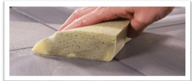
REMARQUE : le coulis ne doit PAS être appliqué autour du pourtour. Toutes les installations doivent inclure des joints mous en utilisant le scellant en silicone à 100 % ARDEX SX<sup>MC</sup> conformément aux normes ANSI A 108.01-3.7 et TCNA EJ 171.
