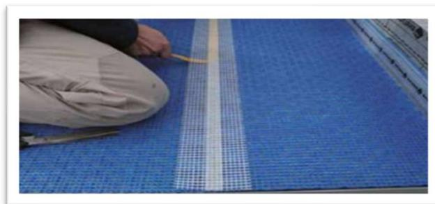
Alignez et joignez les feuilles de la membrane en utilisant la bande de tissu de renforcement des fentes ARDEX UD 58 autoadhésive.
