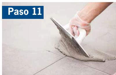
Dado las propiedades de membranas plásticas, los tipos de morteros y de losetas, los posibles tamaños de las losetas, y las condiciones climáticas, el tiempo de curado necesario antes de enlechar puede variar. Sin embargo, los Morteros ARDEX aprobados para su uso con las membranas de desacoplamiento típicamente permiten enlechar después de 3 a 24 horas.
