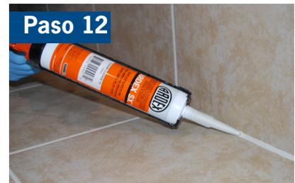
Rellenar las juntas perimetrales y de movimiento con ARDEX SX, ARDEX CA 20 F™ Sellador y adhesivo multiuso para la construcción o un relleno adecuado para juntas suaves.
