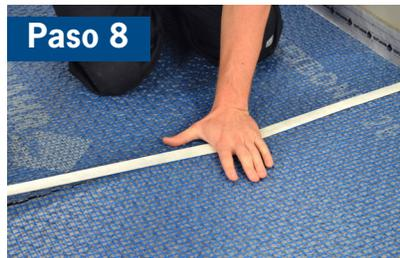
Cubrir las juntas con la cinta autoadhesiva ARDEX UD 156 Cinta para juntas con movimiento para evitar el ingreso de morteros y lechadas.
