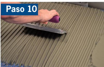
Usar una llana dentada adecuada para peinar el mortero, y luego instalar las losetas o piedras directamente sobre la membrana.
