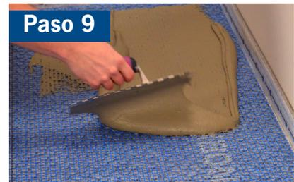
Con el lado liso de una llana dentada, llenar y alisar la ARDEX UI 720 FLEXBONE con mortero hasta que esté al nivel con la superficie de la malla.
