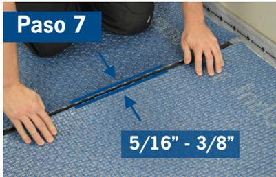
Dejar un ancho mínimo de 8 a 10 mm (de 5/16" a 3/8") para las juntas de dilatación y las juntas perimetrales de campo que subdividen áreas extensas, puertas, etc.
