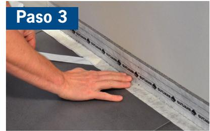
A lo largo de las paredes, columnas, tuberías, y otras penetraciones y estructuras restrictivas del recubrimiento, usar ARDEX UD 146 Cinta para aislamiento de bordes con pie autoadhesivo.
