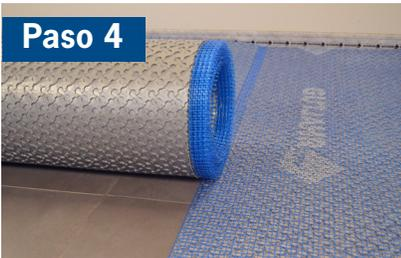
Después de cortar la membrana al tamaño deseado, desenrollar la ARDEX UI 720 FLEXBONE sobre el substrato y colocarlo holgadamente sobre el substrato.
