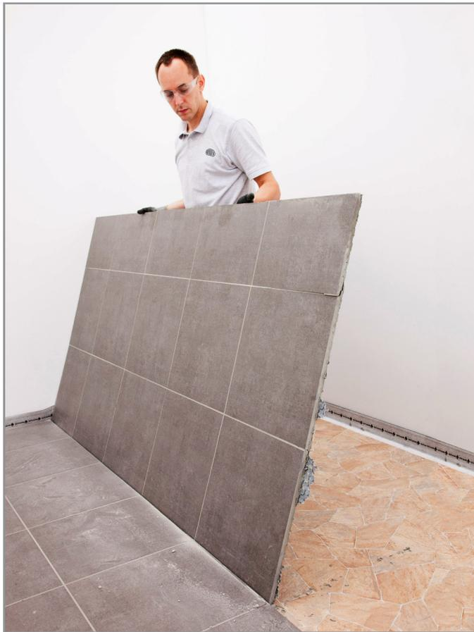
Si se desea cambiar el recubrimiento, colocar una manta plástica sobre el sustrato antes de instalar la ARDEX UI 720 FLEXBONE. La manta plástica funciona como una separadora entre el sustrato y la membrana para proteger contra la adhesión del mortero a utilizarse durante la instalación de las losetas o piedra.
