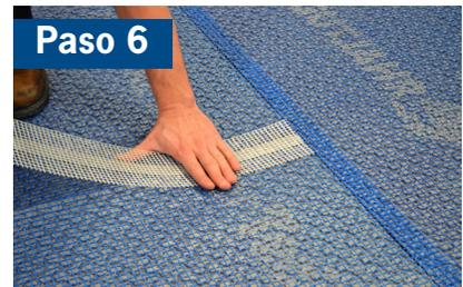
Usar el ARDEX UD 158 Cinta para refuerzo de juntas para adherir las juntas en los extremos y áreas cortadas de la membrana que no tienen los traslpos de malla autoadhesiva.
