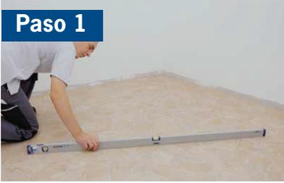
Verificar las calidades para cargas, la planicie y la firmeza estructural del substrato. Si se requiere nivelación, un producto como el ARDEX Liquid BackerBoard se puede usar.
