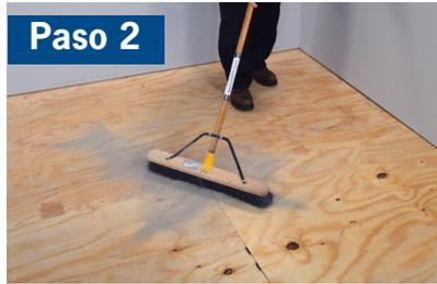
Barrer o pasar un aspirador sobre el substrato. En áreas intermetentamete húmedas o donde se requiere impermeabilización, los substratos sensibles a la humedad, como el yeso, hay que protegerse de daños causados por el agua a través de imprimir con el ARDEX P 51 e instalar el ARDEX 8+9
